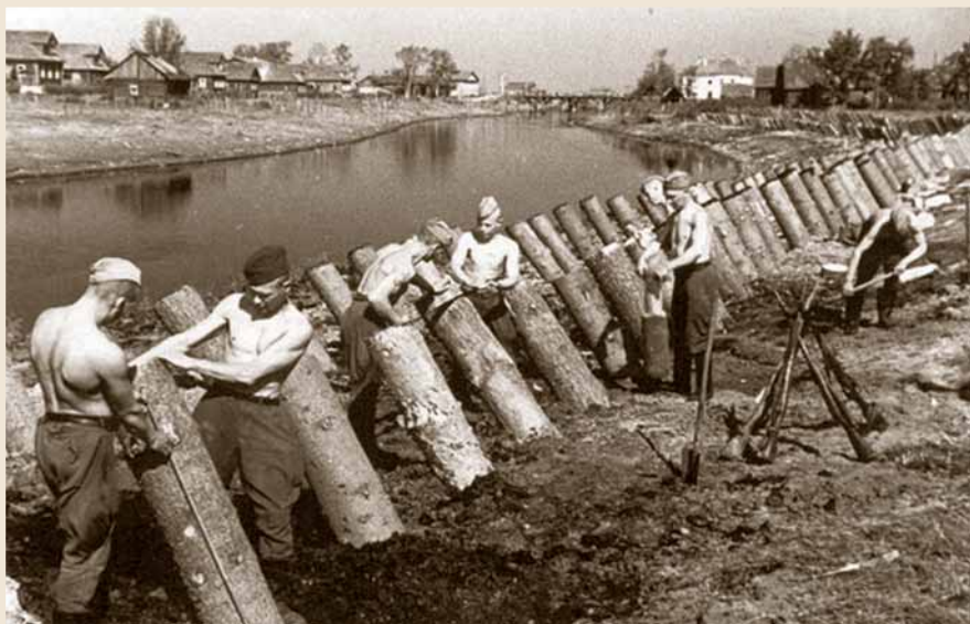
Бойцы Волховского фронта сооружают противотанковые препятствия.
