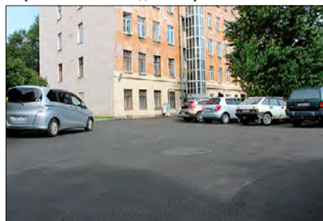
Замена асфальтового покрытия на ул. Арсенальной, д. 1
